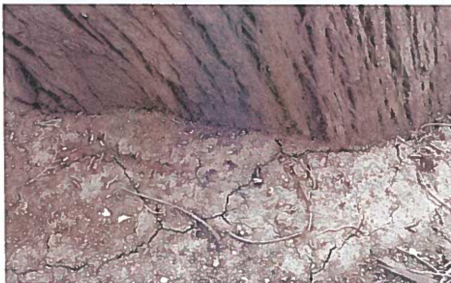
foto 12 - Cimitero Monumentale S.Lazzaro di Viterbo. Altre fessurazioni al colletto e sul terreno intorno all'albero in un esemplare posto in classe CPR 2.
