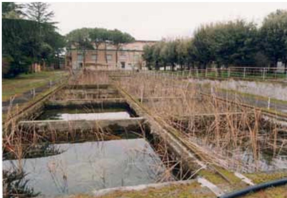
da sei a tre, e, in **Figura 7 - Lo stato di abbandono delle vasche di maturazione del fango** due o tre casi, a uno e a due letti.
