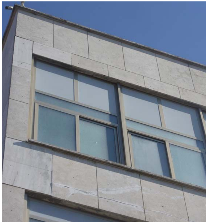
Figura 3. Paramento esterno in lastre di travertino
